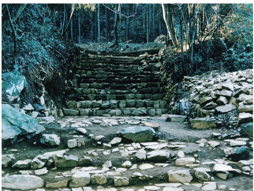
図 40 八王子城跡御主殿虎口の調査状況 引用元は図 37 に同じ。
